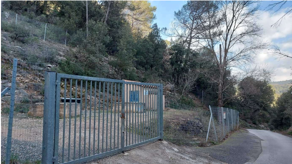
Figure 4. Têtes béton des 2 forages de Vigne Groussière
